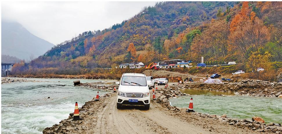
经过汉中市公路局连续20天的艰苦奋战,因山体发生重大滑坡导致交通中断的244国道留坝姜窝子路段通行便道于11月20日抢通。据项目部负责人介绍,该便道实施长度1000米,路基宽度7米,可满足三轴以下车辆通行条件。目前已承接对社会车辆有序开放交通,其余尾留配套项目将在本月底全部完成。文/图 徐立生
