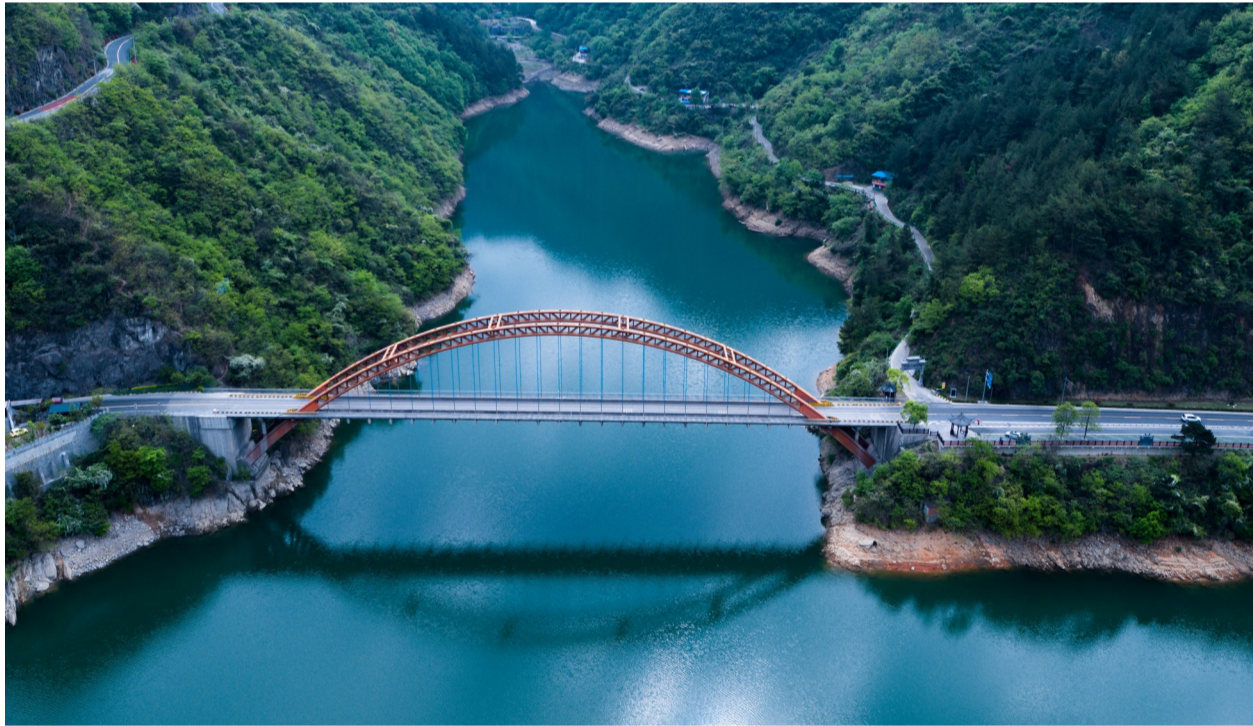
国道316汉台襄河潘家河大桥
