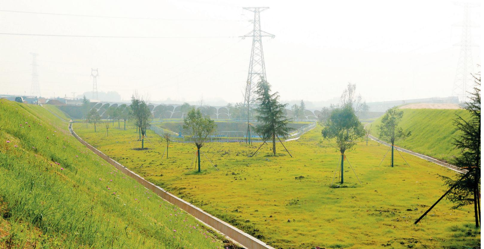
我省在高速公路边坡防护,尤其是生物防护中一直有许多积极的尝试,日前在建设中的鄂周眉高速公路水寨立交区路基边坡防护工程中,使用植物纤维毯技术,边坡绿化效果明显,这种以农作物秸秆为基底,混合灌草种籽、营养剂的复合型生态材料,铺设后前期可抵御雨水冲刷,为种子提供适宜发芽环境,后期植物根系与坡面形成整体防护体系,兼具防风固沙与景观提升功能。据介绍,该技术施工效率极高,8-10人小组日均铺设可达500米,且全程无施工垃圾与噪音污染。
