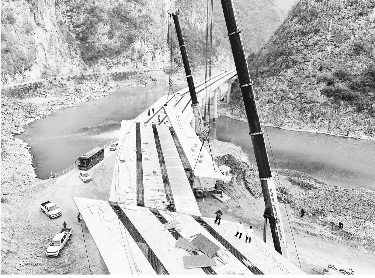
1月26日,随着最后一片箱梁平稳精准就位,由陕西华通公路工程公司施工的金钱河大桥箱梁架设全部完成,该项目施工难度最大、技术最复杂的控制性工程
