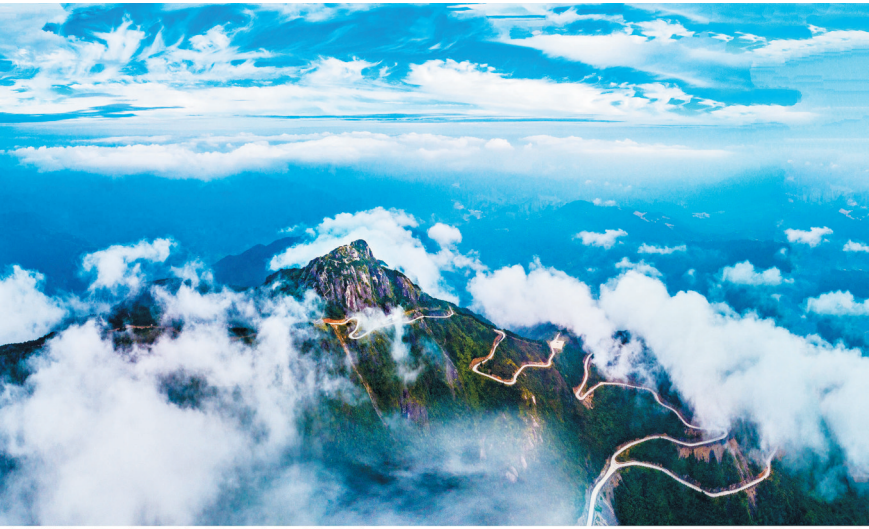
《新美乡村路》（组照）青田县温坑乡，乡道温坑至金坑山 作者：陈世丰
