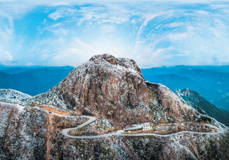
《新美乡村路》（组照）（青田县温坑乡，乡道温坑至金坑山） 作者：陈世丰
