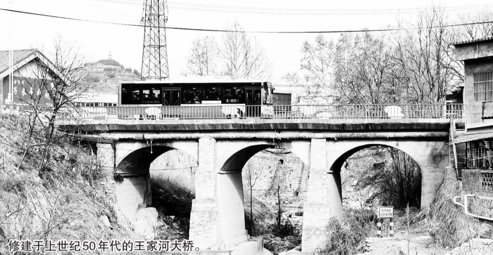
修建于上世纪50年代的王家河大桥。
