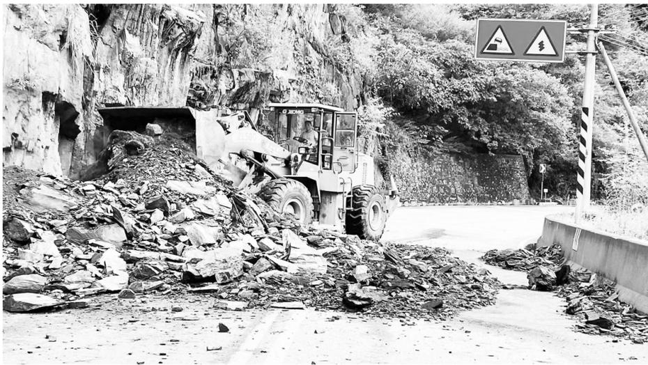
近日,受连续降雨天气影响,汉台公路段辖养的244国道K1450+500-K1450+515处突发山体塌方,土石覆盖路面,导致交通中断。在确保山体边坡状况稳定安全
