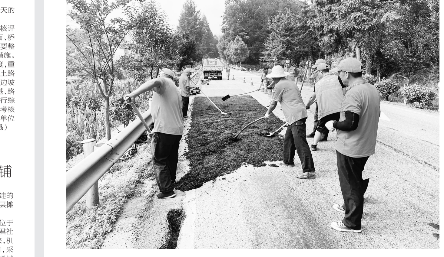
近日,南郑公路段在做好日常养护和防汛抢险工作的同时,加大公路预防性养护实施力度。该段紧抓有利天气,迅速完成对辖区公路路面裂缝、坑槽等病害的修复处置工作,有效延缓路面病害发展速度,延长公路使用年限。 文 / 图 张福涛 张洵
