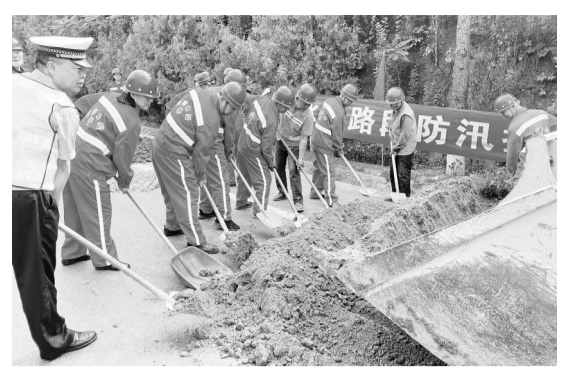
白水公路段开展防汛抢险应急演练
