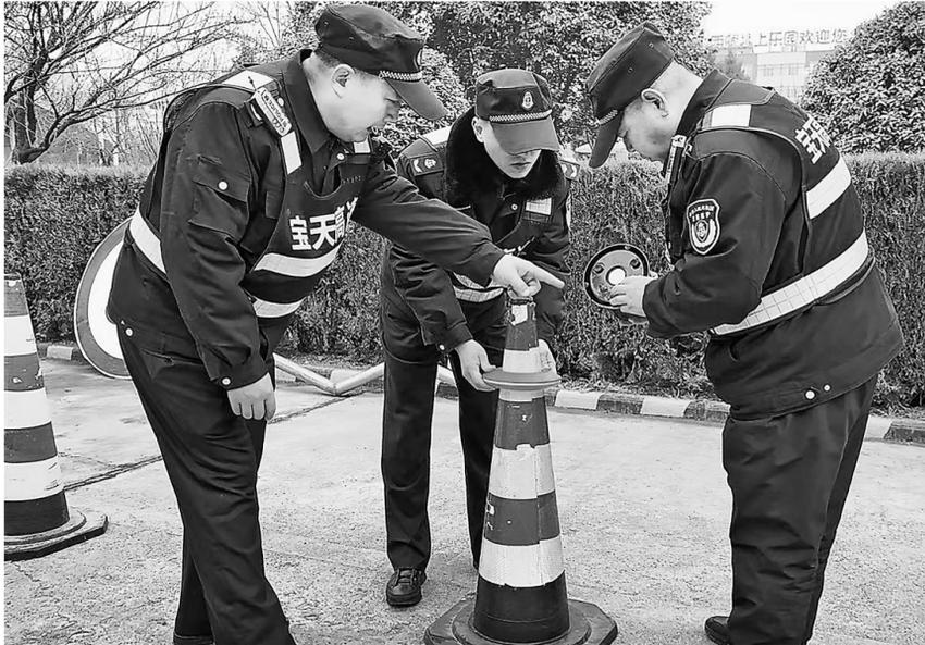
日前,宝天分公司宝鸡路产养护管理中心在施工现场引进“防闯入预警系统”设备。该设备是用于道路交通作业现场的新型安全防护
