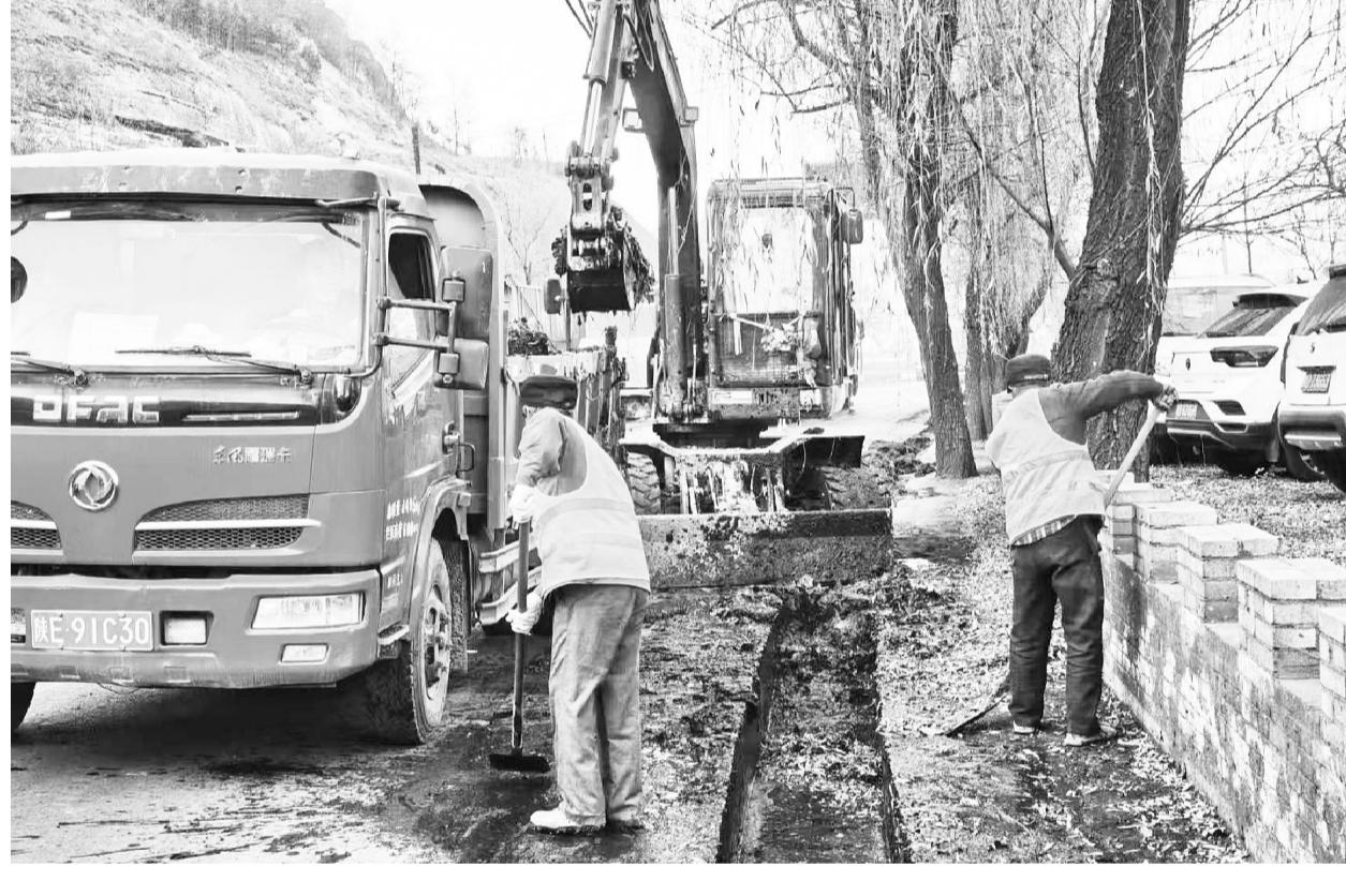
近期,咸阳市公路局长武管理段聚焦整治路面病害,坚持“快补、勤补”原则,按照“切割、清槽、吹扫、压实”标准流程,用冷补料修补坑槽,累计修补坑槽210平方米。
