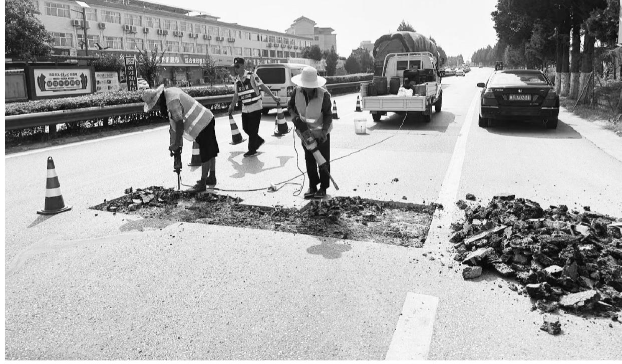
近日,汉中市持续发布高温橙色预警,在316国道养护工程作业现场,地表温度高达47℃。汉台公路段养护人员不惧高温,严格按照“八道工序法”修补路面坑槽,经过“划线、切割、开槽、清底、洒油、铺料、碾压”等环节,对坑槽部位实施精细化修补作业,先用切割机精准切割破损区域,将松散废料彻底清除,形成平整的修补基面。洒布乳化沥青底油后,随即倒入170℃以上的热拌沥青混凝土,人工迅速摊铺平整。最
