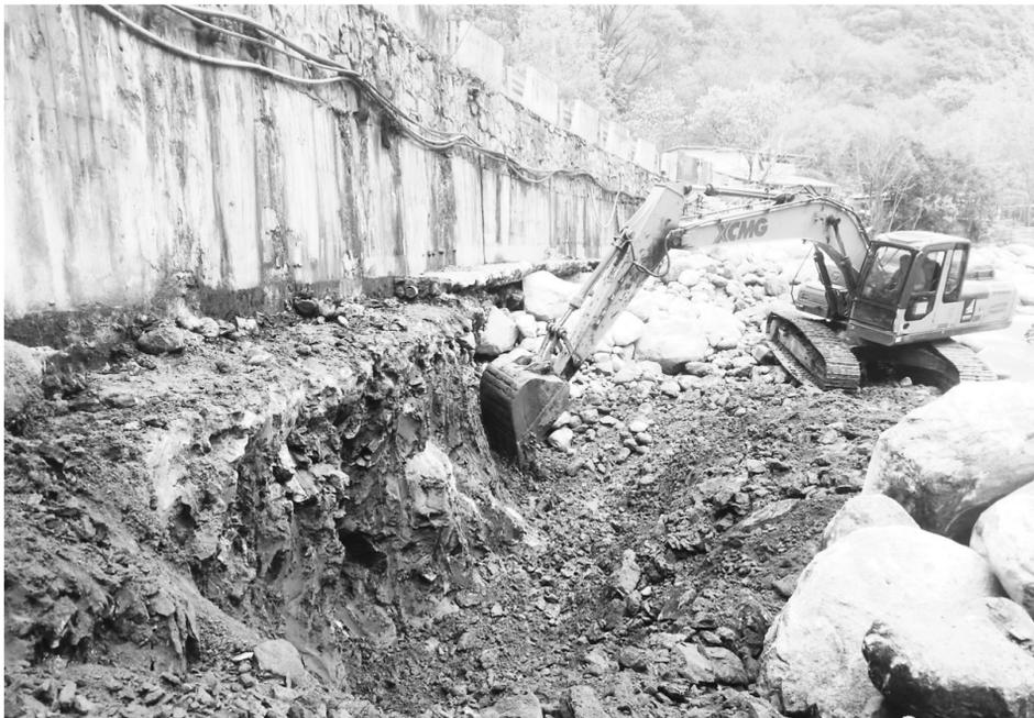
近日,洋峪公路管理段在路况调查中发现,210国道(长安段)K1324+360、K1322+090、K1335+440临河路基受河水冲刷,路肩墙基被掏空,挡墙损毁、波形钢板和
