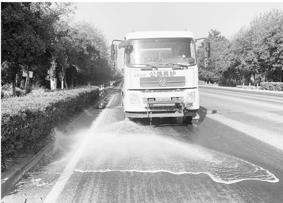
随着冬季来临,大气污染防治也进入了关键时期。阎良公路段组织人员对存在灰带的路段先实行人工铲除,再由水车进行冲洗,最后由清扫车进行清扫,确保全方
