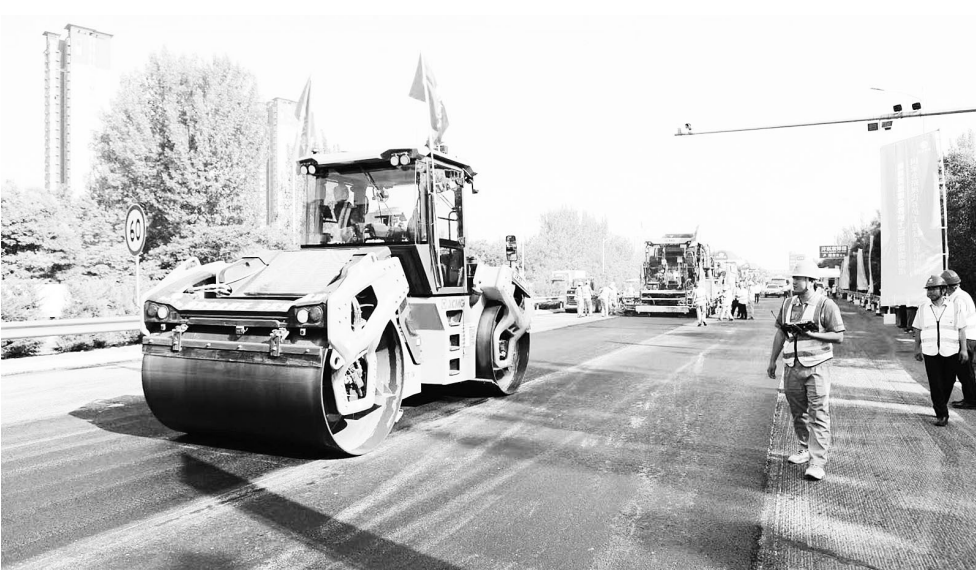
图：高速公路施工现场，大型压路机正在作业。
